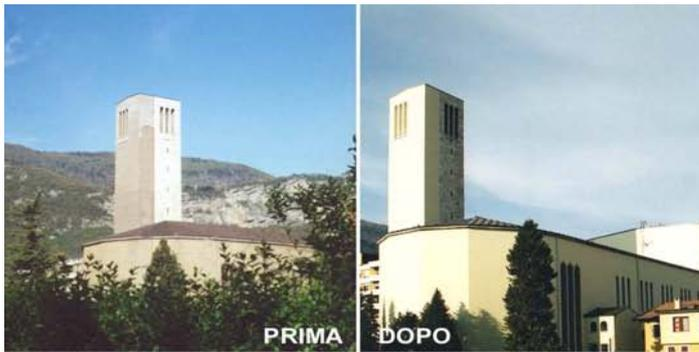
la posa di nuovi pluviali esterni alla parete, agganciati al coronamento di gronda con cassette sagomate di raccolta dell'acqua piovana. Sulle facciate esterne è stato posato un nuovo intonaco armato con fibre per garantire una migliore resistenza meccanica atta ad impedire microfessurazioni e a prevenire l'aggressione degli agenti esterni.
